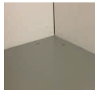
Sol avec revêtement PVC
